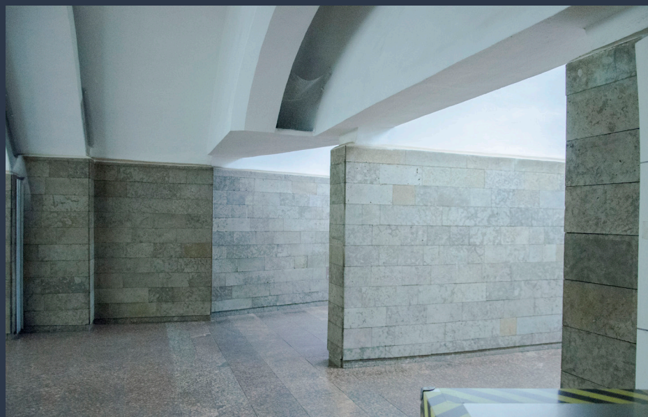
Переход станции метро «Достоевская»
